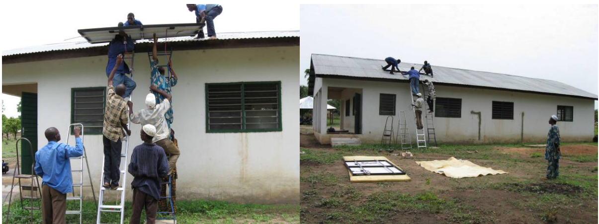
Installation der Solarpanele auf dem Dach der Gesundheitsstation
