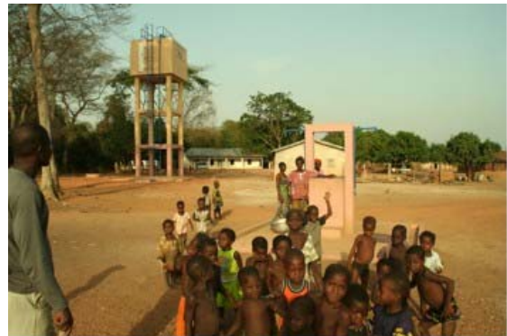
Wasserturm und Wasserstellen in Dogué
